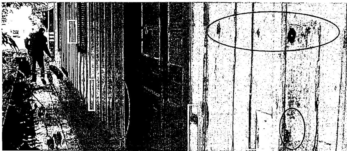
Foto 09 – Círculos infestação de cupins, retângulos placas de PVC ocultando infestação de cupins.
